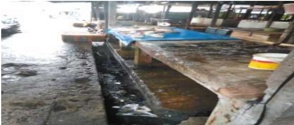
Gambar 3. Kondisi Umum Pasar Tua
